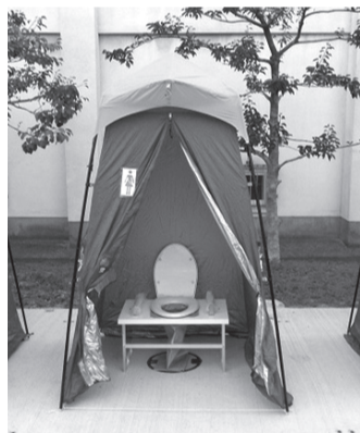
マンホールトイレ
